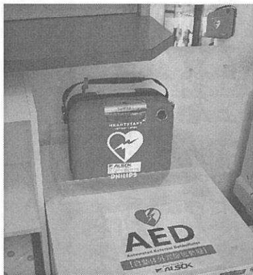
助成頂いたAEDを職員室に設置させて頂きました！
