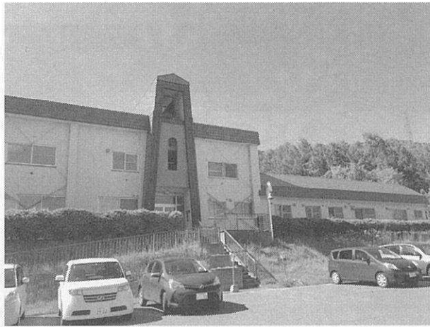
改修前の支援センター(^^)♪ 青い屋根がまぶしい!
