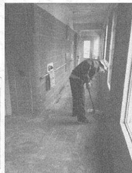
道営住宅の清掃作業
